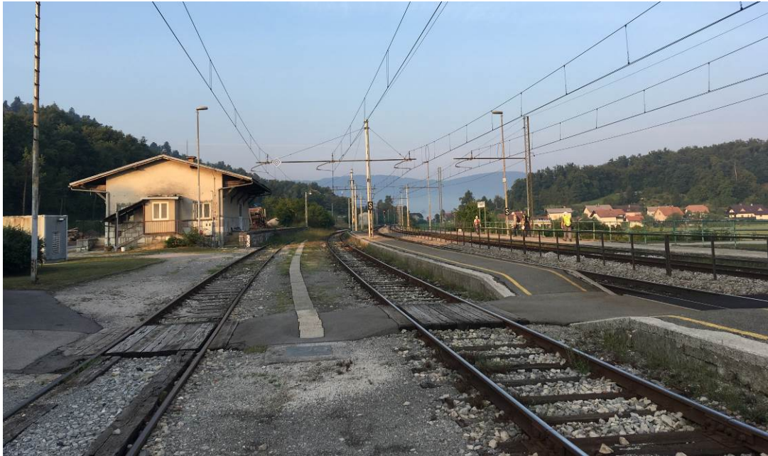
Slika 6: Obstoječ nivojski prehod za dostop potnikov na otočni in bočni peron
